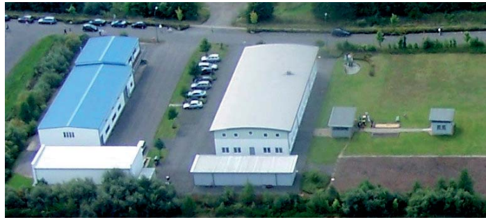
EBINGER Technikzentrum Wiesbaum
